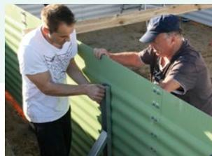
Placez sur le sol les plots réglables (fournis). Posez les panneaux d'acier et les jambes de force sur les plots. Assemblez-les par boulonnage. Réglez facilement le niveau à l'aide des plots réglables.
