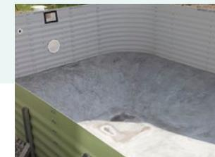
Réalisez une simple chape d'environ 5 cm d'épaisseur directement sur un sol compacté (sans ferrailage ni béton).
