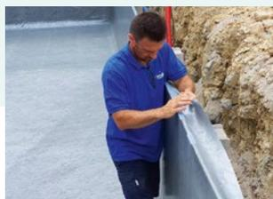
Dépliez le liner au fond du bassin, faites-le remonter le long des parois en débordant sur le côté extérieur, puis clipsez-le. La pression de l'eau va plaquer le liner sur les bords et le fond.
